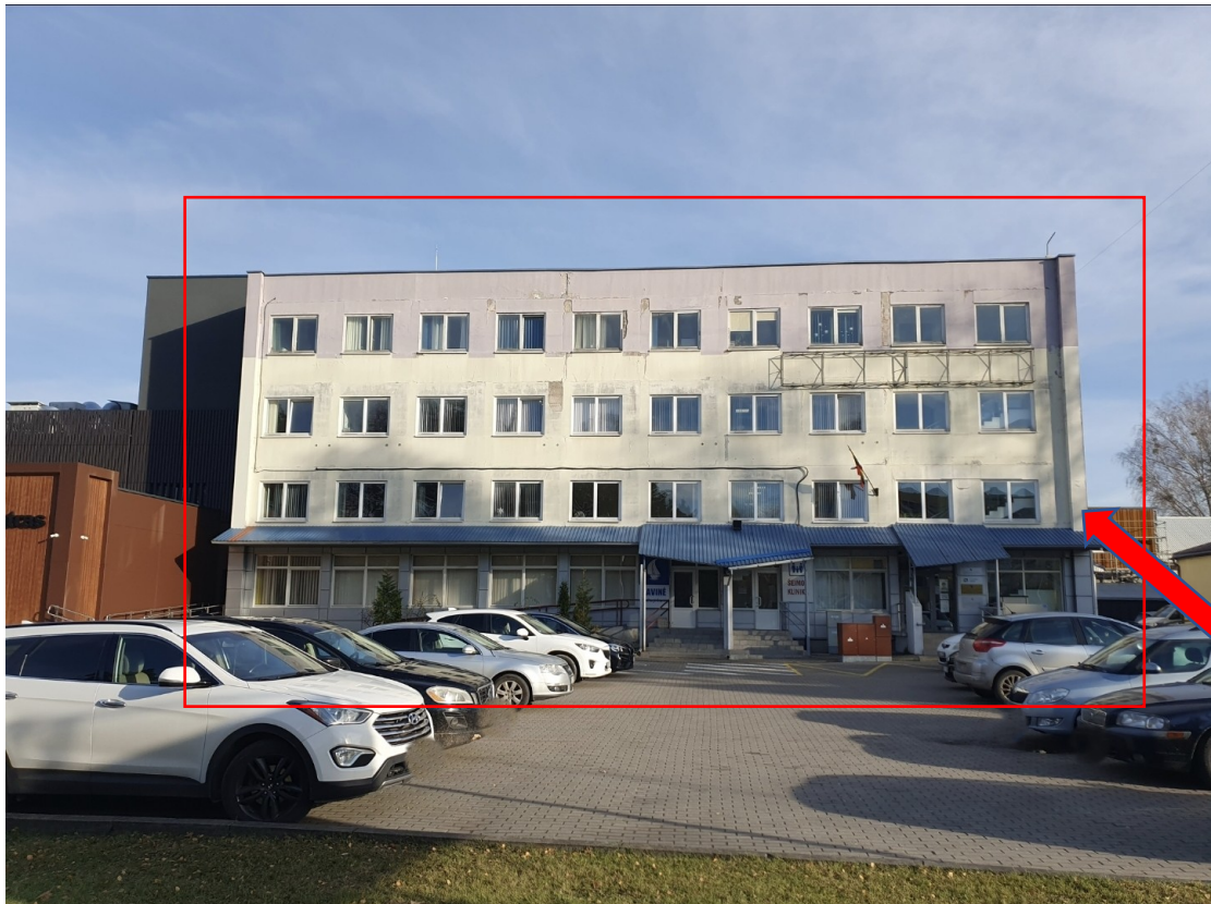
Fotonuotrauka Nr. 1 Remontuojamas Administracinis pastatas (unikalus Nr. 5197-5008-3020), S. Daukanto g. 19, Kazlų Rūdoje, pažymėtas raudonu kontūru. Vaizdas iš vakarinės pusės nuo S. Daukanto gatvės.
